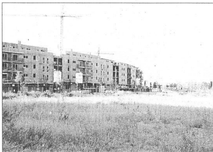
El 'boom' de la construcción también ha llegado a la zona oeste. / JUANRA
