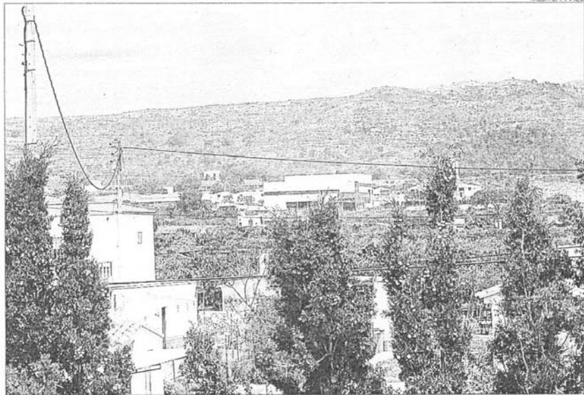
La zona afectada está situada detrás del cementerio de San José.
